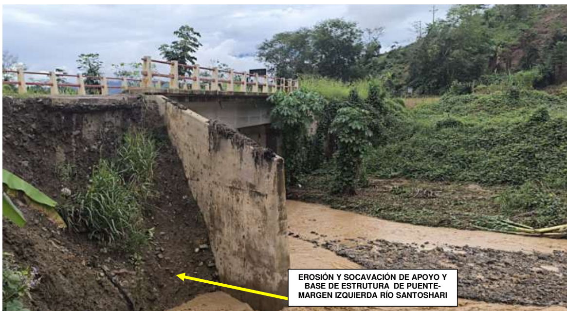
FIGURA N°03: VISTA DE AFECTACIÓN DE BASES DE LA ESTRUCTURA DE PUENTE VEHICULAR DEBIDO A LA FUERZA EROSIVA DEL RÍO SANTOSHARI
