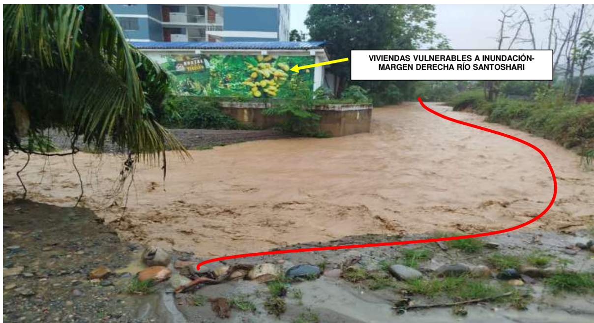
FIGURA N°02: VISTA DE VIVIENDAS VULNERABLES A INUNDACIÓN POR AUMENTO DEL CAUDAL DEL RÍO SANTOSHARI. SE OBSERVA QUE EL RÍO VIENE SOCAVANDO Y EROSIONANDO LAS BASES DE LAS ESTRUCTURAS.
