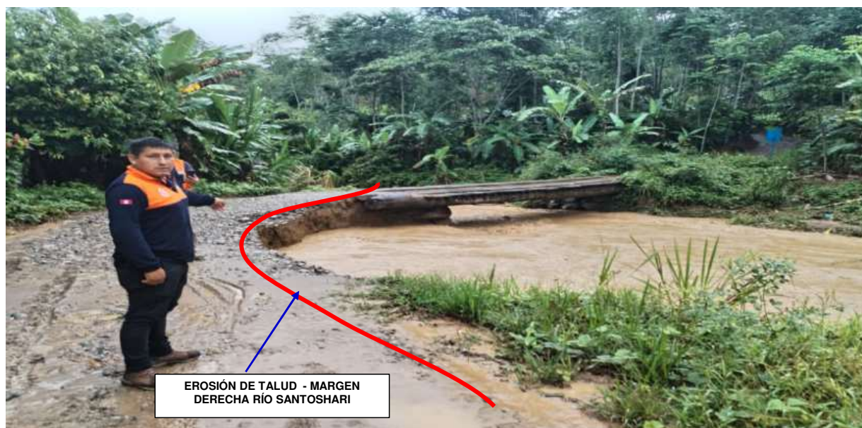
FIGURA N°01: TRAMO CRÍTICO EN EL RÍO SANTOSHARI, EN EL SECTOR MANTARO, DISTRITO DE UNIÓN ASHÁNINKA, PROVINCIA DE LA CONVENCION - CUSCO. EROSIÓN DE TALUD DE LA MARGEN DERECHA DEL RÍO SANTOSHARI. AFECTACIÓN DE CARRETERA DE CONEXIÓN VIAL
